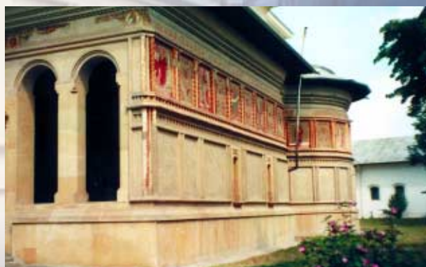
Jeden z budynków pięknego kompleksu klasztorowego w miejscowości Czernica pod Bukaresztem
